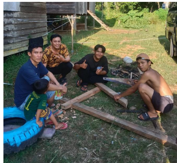
Gambar 4. Pembuatan Tiang Penerangan Jalan Umum (PJUTS)
